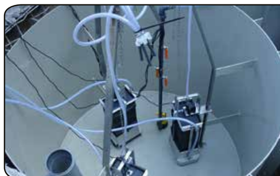
3 BMT modules in ondergrondse tank.
